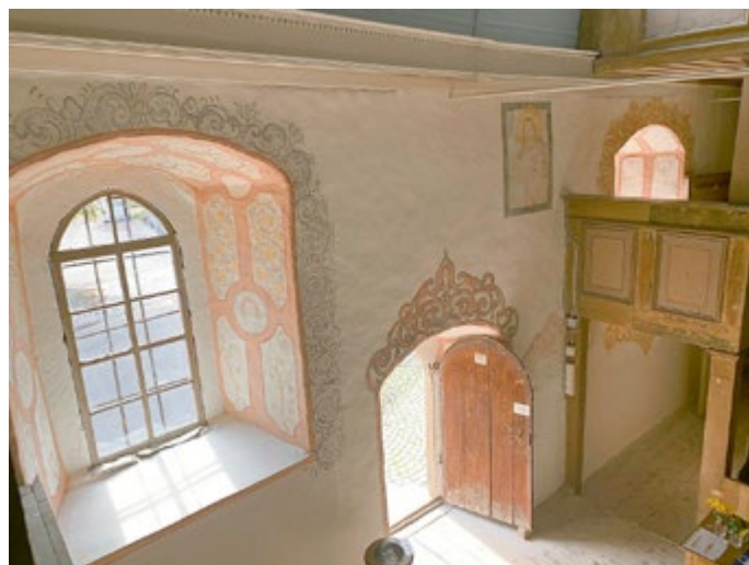
Restauration Kirche Schwansee
