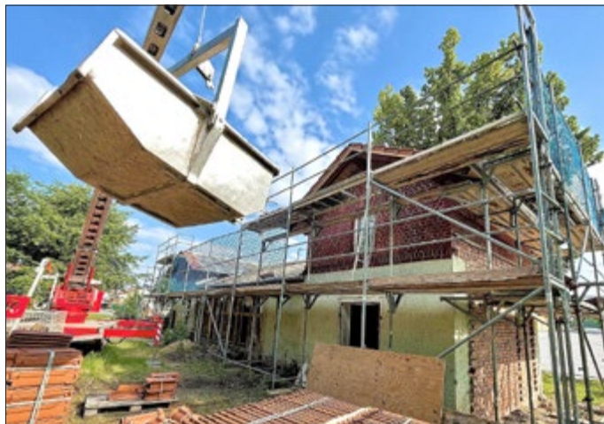
Die Dachdeckerarbeiten sind fast abgeschlossen.
